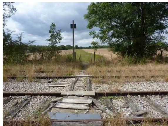
Figure 75 : Acqueduc de de l'Avre au franchissement des voies désaffectées (Bailly)
