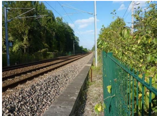
Figure 101 : Voies aménagées au Sud de la gare de Mareil-Marly
