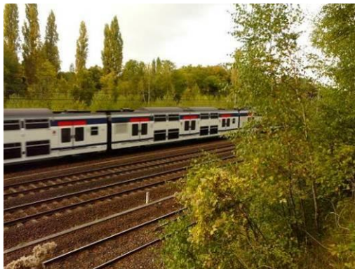
Figure 73 : Voies ferrées circulées entretenues et dépourvues de végétation (Secteur du pont des Ambassadeurs)
