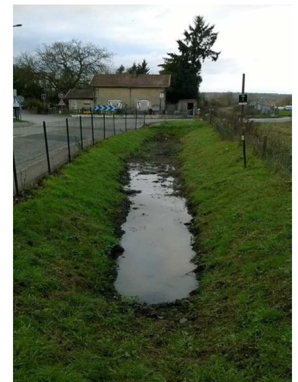
Figure 79 : Vue du fossé/zone de rétention à proximité du PN1
