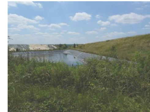
Figure 124 : Bassin d'orage de l'A12
