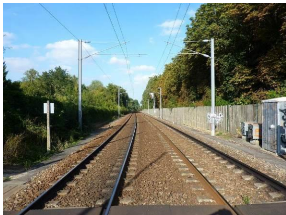
Figure 105 : Future gare de l'Étang-la-Ville (voies circulées et parc boisé)
