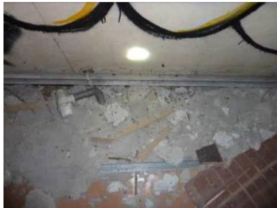
Figure 123 : Guano de chauves-souris dans l'entrepôt au Nord de Saint-Germain-en-Laye (source : IEA)
