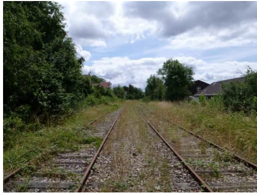
Figure 108 : Passage en agglomération
