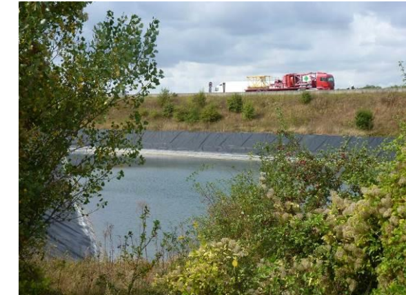
Figure 78 : bassin d'orage Sud A12
