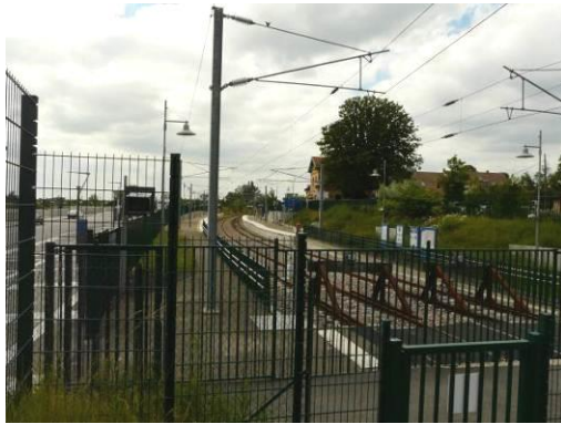
Figure 72 : Aspect minéral et urbanisé du couloir ferroviaire aménagé à Noisy-le-Roi
