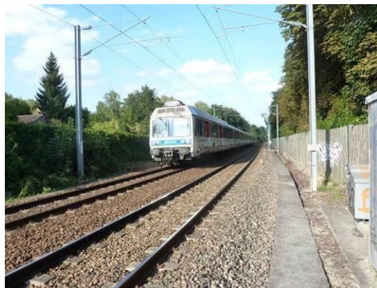
Figure 102 : Voies circulées au niveau de la future gare de L'Etang-la-Ville
