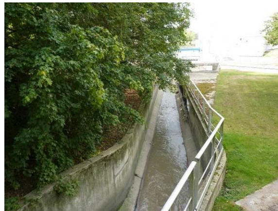
Figure 74 : Ruisseau de Gally entre la station d'épuration et le tracé
