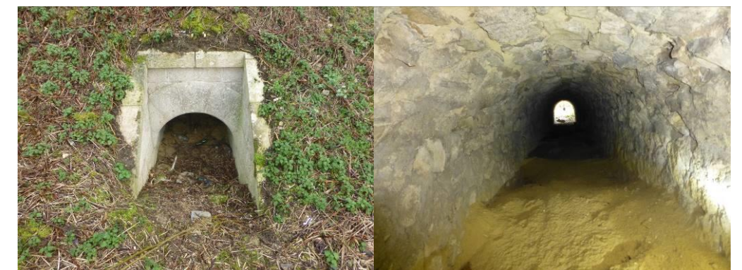
Figure 128 : ouvrage mixte hydraulique proche de la RD 307 (source : IEA)
