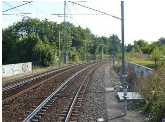
Figure 100 : Voies aménagées au droit de la gare de Mareil-Marly
