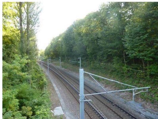
Figure 104 : Voies aménagées au Sud de la gare de Saint-Nom-la-Bretèche
