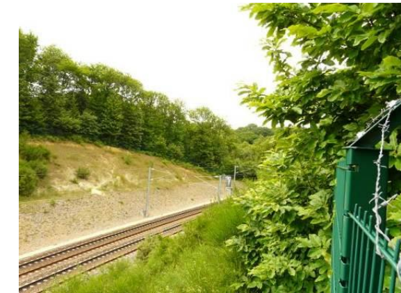
Figure 107 : Voies nouvelles aménagées en tranchée à la sortie Sud de la forêt de Marly (cliché de 2008)
